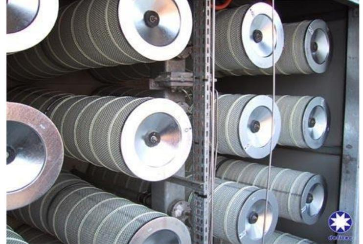
**L'impianto filtro di aspirazione può contenere fino a 500 elementi o cartucce filtranti orientati in senso orizzontale. Tipicamente arrotondate o rettangolare in formato.**
